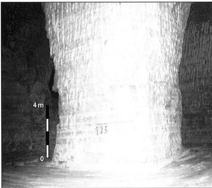
Figure 3.5 - Livry Gargan – Age d'exploitation récent Remblayage partiel des chambres
