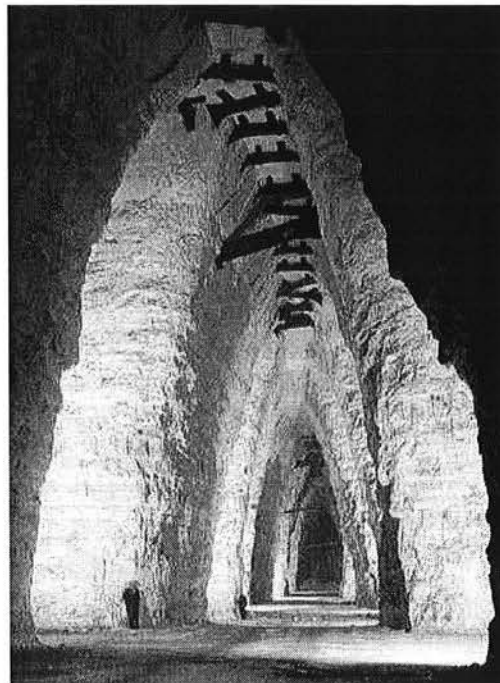
Figure 1.2 - Exploitation par chambres hautes en ogive, Livry Gargan
