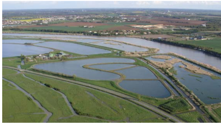
Figure I-3 : Station de lagunage de Rochefort (Charente-Maritime).
