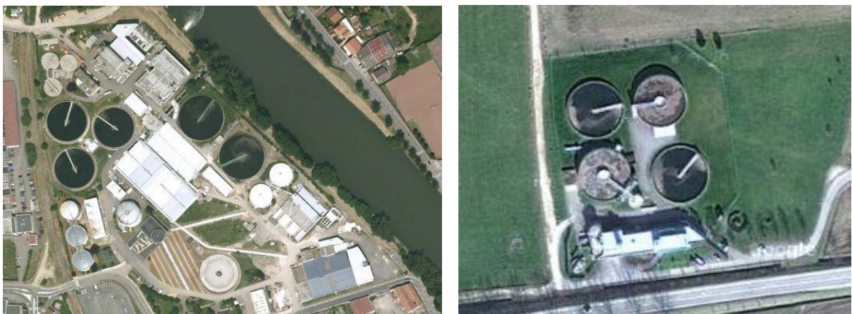
Figure II-2 : Stations d'épuration de Nancy-Maxéville (à gauche) et de Pont-à-Mousson (à droite) vues du ciel [source Google Map].
