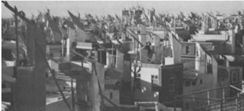
Figure 2 : Toitures du quartier bas de Sind, au Pakistan. Installation dans chaque pièce des bag-gir ("capteur à vent"). (Rudofsky, 1977, p114).
