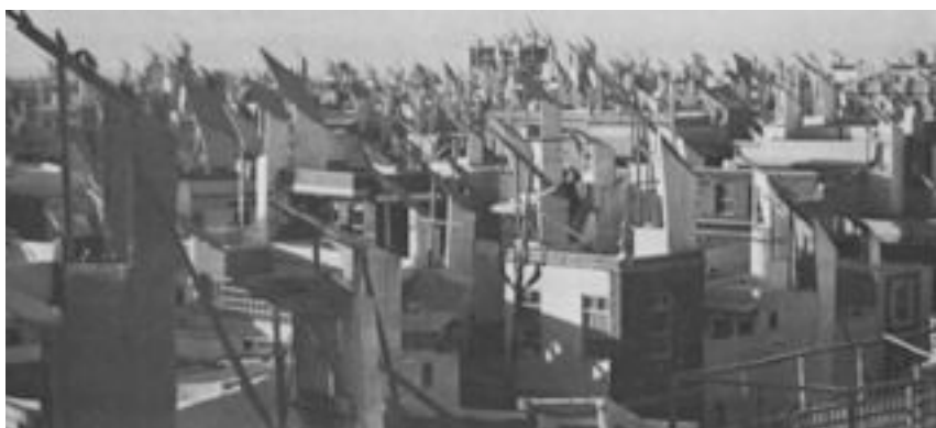
Figure 2 : Toitures du quartier bas de Sind, au Pakistan. Installation dans chaque pièce des bag-gir ("capteur à vent"). (Rudofsky, 1977, p114).
