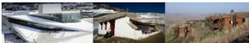
Figure 39 : Exemples de projets étrangers explorés lors des études de cas. Gauche : nouvel opéra/ballet national de Norvège à Oslo de l'architecte Snohetta (Snohetta, WEB). Milieu : Surya school (Himalaya) en Inde, dirigée par Jan Tillinger (Surya Civic Association, WEB). Droite : loge de montagne en Afrique du Sud des architectes Crafford and Crafford (Crafford & Crafford, WEB).
