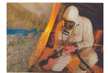
Opération de « bouchardage » de bétons : attaque mécanique.
