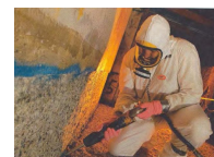
Opération de « bouchardage » de bétons : attaque mécanique.
