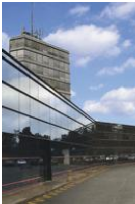
Figure 7– Le Centre de Médecine Préventive de Vandœuvre-lès-Nancy.
