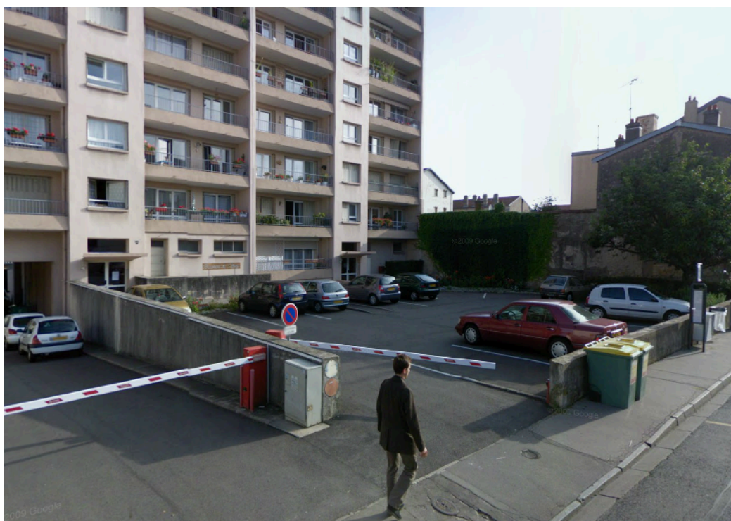
Photographie 8 : Une barre en ville, rue Gabriel Mouilleron à Nancy. Elle est en retrait par rapport à la voie, l'espace intermédiaire est protégé par des murets et des barrières. Devant la façade est fixé un panneau en bois sur lequel il est écrit : « Résidence de l'Etang ».
