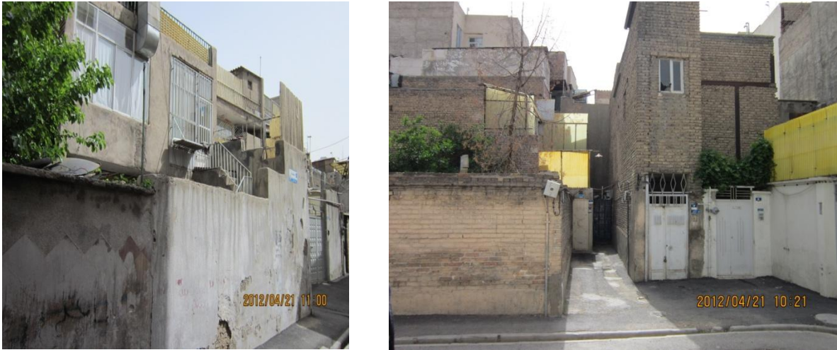
Figure 75 : le quartier Safa, la qualité des bâtiments est trop faible.
