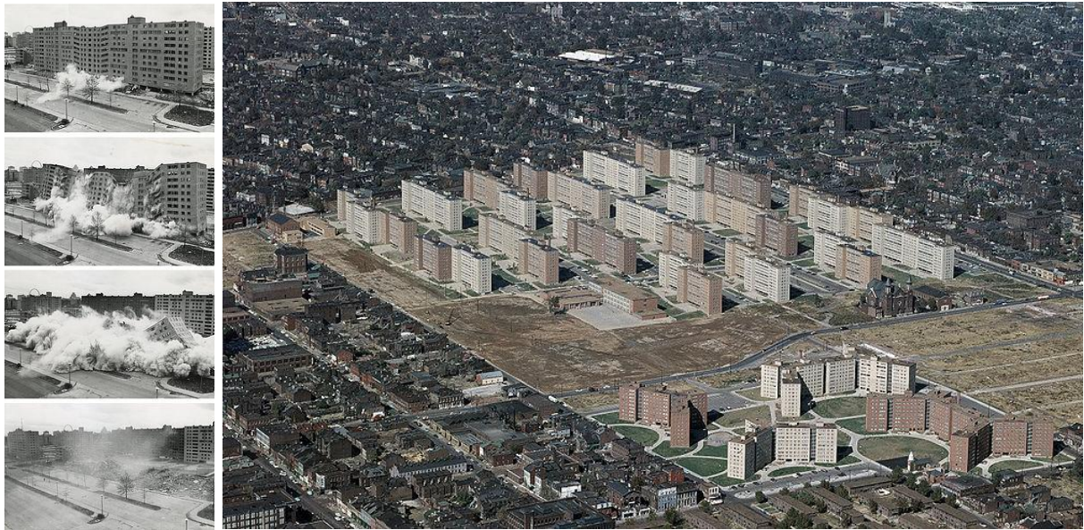
Figure 1 : Pruitt Igoe était un grand projet de logements urbains premier occupée en 1954. À la fin des années 1960, le complexe est devenu tristement célèbre internationalement pour sa pauvreté, la criminalité et la ségrégation. Ses 33 bâtiments ont été démolis au milieu des années 1970 (Eggener 2004)
