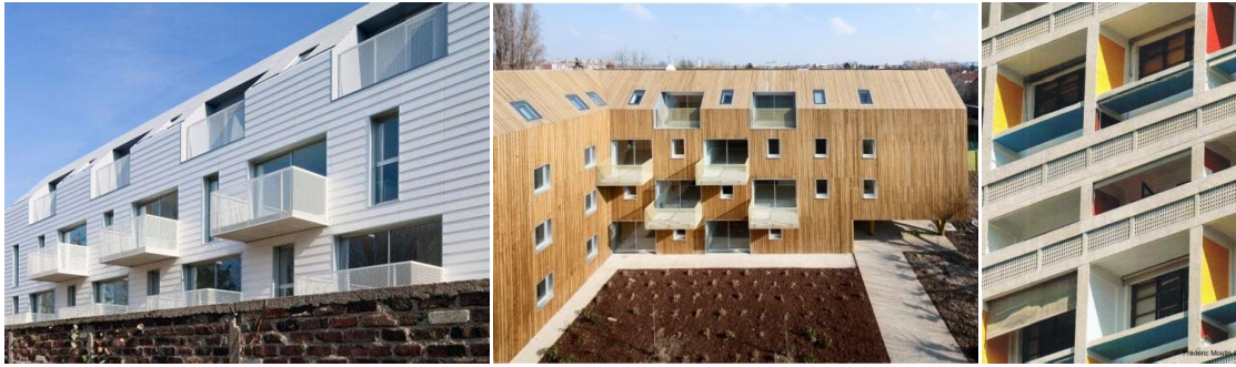
Figure 44 – Façade, composées d'ouvertures et de murs
