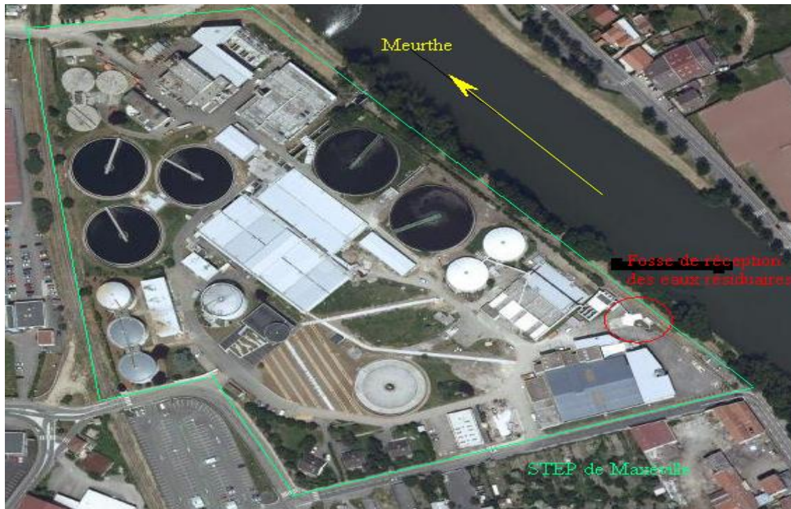
Figure 2.1 : Vue globale de la station d'épuration (STEP) de Maxéville–Grand Nancy (Google Earth)
