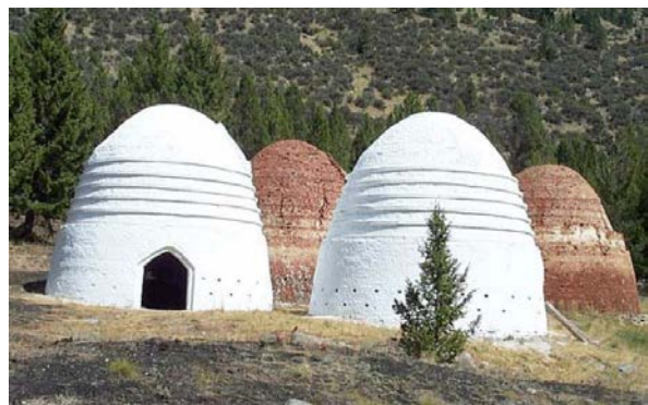
Figure 16 : Exemple de fours traditionnels, une meule en terre à gauche et un four dit en « nid d'abeille » à droite (FAO 2008)
