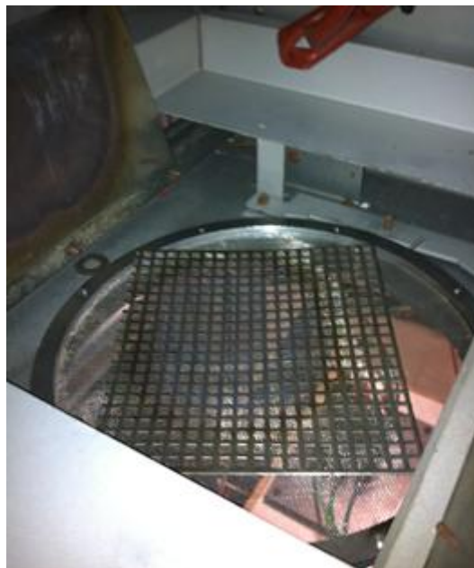
Figure II-4. Mise en place des grilles 1 et 2 sur l'ouverture de la lampe.
