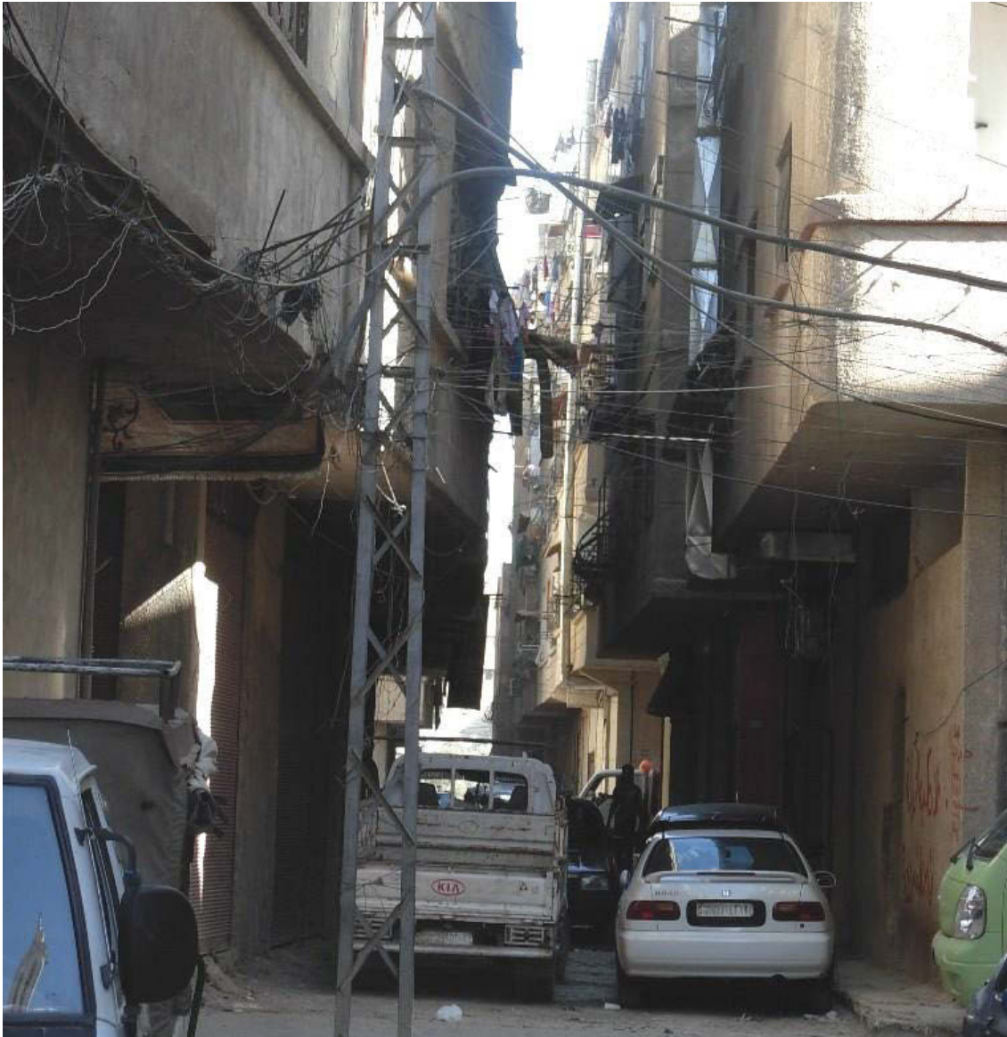
Cliché 35 : Extension sur la rue du premier étage. La sortie en encorbellement du premier étage sur la rue, afin d'agrandir la surface habitable, est une règle quasi générale. Cliché : Main Kafa, zone de Tadamoun mars 2010
