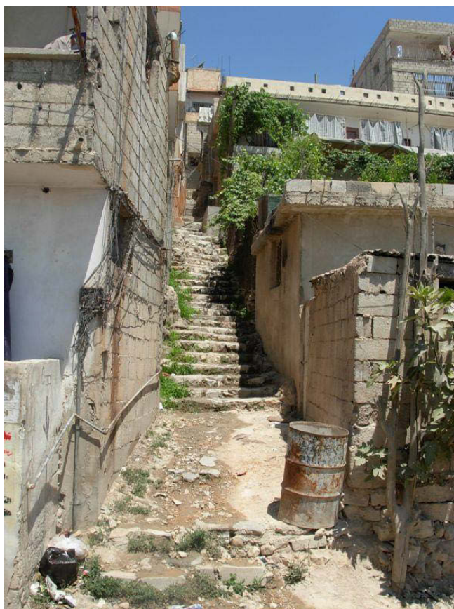
Cliché 39 : un escalier public dans la zone accidentée de Mazzé 86. Les escaliers, malgré leur mauvais état, restent un des moyens de communication les plus répandus dans les zones non réglementaires de la montagne. Cliché : Main KAFA, mars 2010
