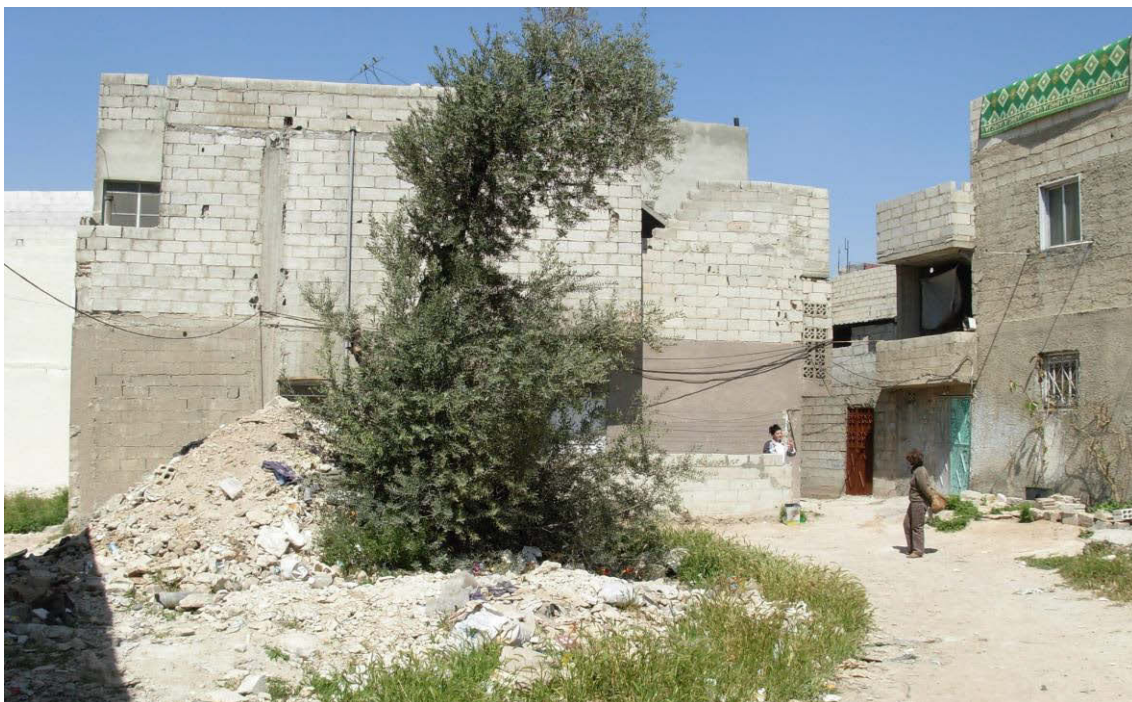
Cliché 19 : vestiges de la Ghouta à Kaboun. Les oliviers ont été abattus pour construire les maisons. Un de ceux-ci a survécu au milieu d'un tas de gravats du chantier de construction. Cliché : Main KAFA, mars 2010
