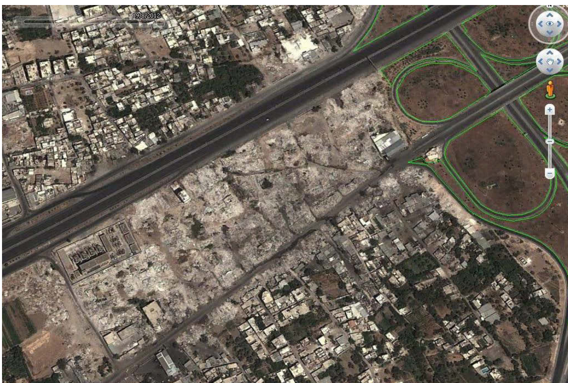
Cliché 50 : Destructions dans le quartier informel de Kaboun. Ces deux images présentent un secteur du quartier en mai 2011 et août 2012. On voit bien que ce secteur a été complètement détruit (environ 150 bâtiments sont rasés), suite à des confrontations permanentes entre l'armée syrienne et l'armée d'opposition au régime ; confrontations qui se sont poursuivies depuis la fin 2011. Source : Google Earth
