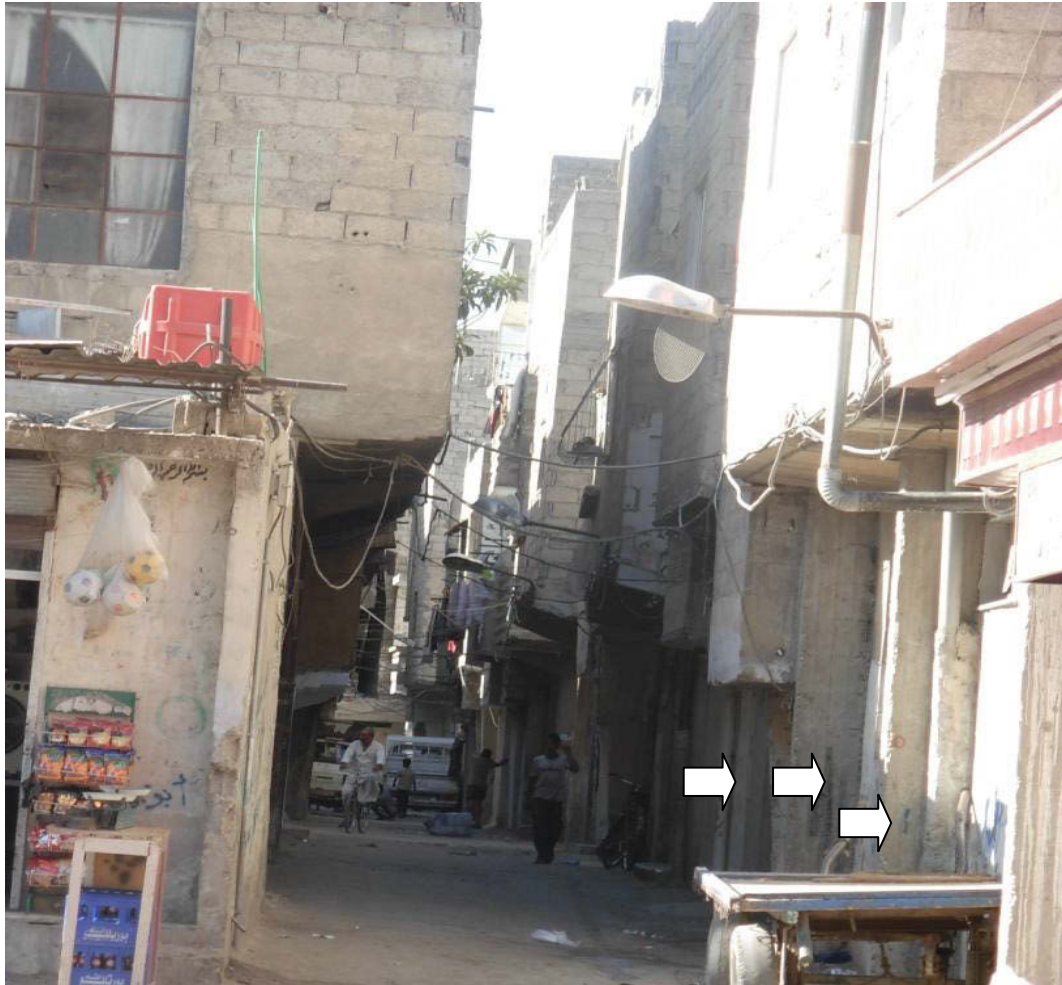
Cliché 38 : Architecture à encorbellements à Tadamoun. Des piliers sont ajoutés pour permettre la construction d'un deuxième étage, cas fort répandu à Tadamoun. Cliché : Main KAFA, juillet 2009
