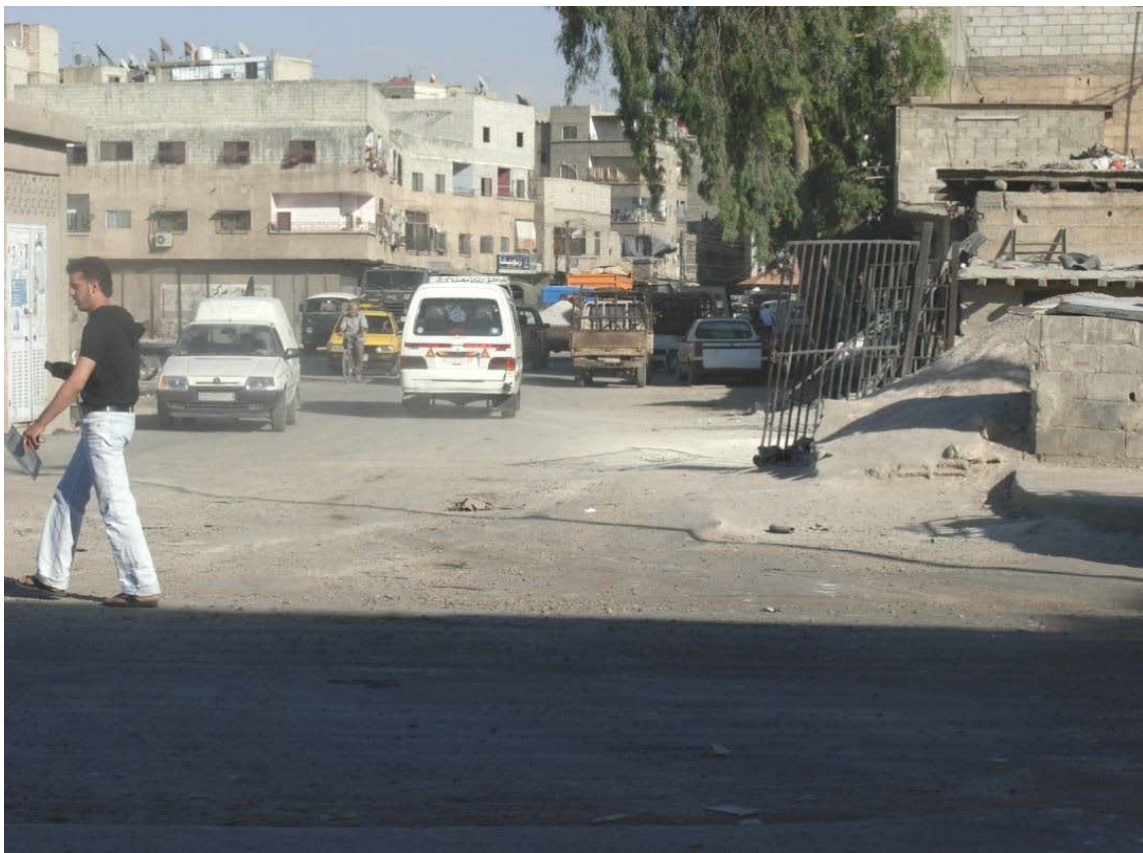
Cliché 29 : Maisons non achevées et sans finitions extérieures. Exemple dans la zone d'habitat non réglementaire de Tadamoun. Les maisons font de 2 à 3 étages. On remarque que le dernier étage n'a pas encore été achevé ; il restera sans doute longtemps ainsi. Les maisons ont été construites sur des terrains expropriés par la Mohafaza de Damas. Cliché : Main KAFA, juillet 2009
