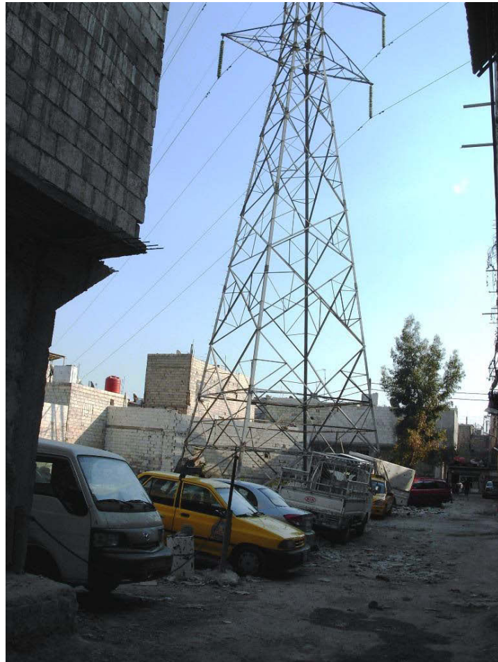
Cliché 18 : Exemple de risque dans les zones d'habitat informel. Ici le réseau d'électricité à haute tension passe au-dessus de certaines maisons du quartier de Hay Tichrine ; un accident peut faire des dizaines des victimes. Cliché : Main KAFA, mars 2010
