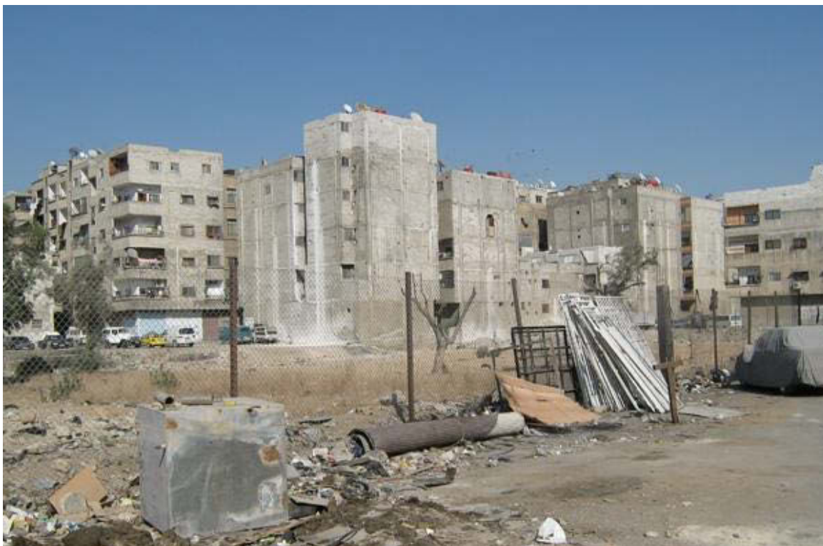
Cliché 37 : Habitat informel vertical . Les bâtiments à étages sont les plus répandus à Daf Alchouk. On y trouve des bâtiments jusqu'à 7 étages, et à chaque étage, un à deux logements. Cliché : Main KAFA, mars 2010
