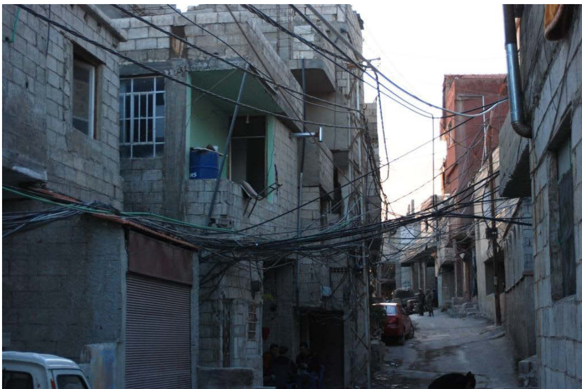
Cliché 43 : les réseaux à Uch Alwarwar. Les réseaux d'eau, d'électricité et de téléphone forment une véritable toile d'araignée qui encombre les ruelles. Cliché André HUMBERT 2010
