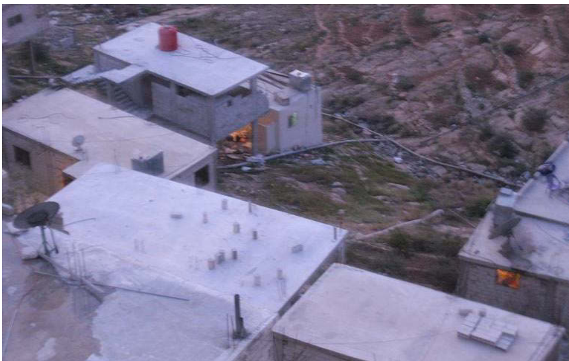
Cliché 41 : Branchements sauvages à Uch Alwarwar. Parfois, les raccordements au réseau d'assainissement de la ville sont des branchements sauvages ; bien évidemment non conformes. On voit sur cette photo d'Uch Alwarwar les conduits en plastique qui traversent la vallée et parfois les routes à l'air libre, sans aucune protection. Cliché : Main KAFA, Janvier 2011
