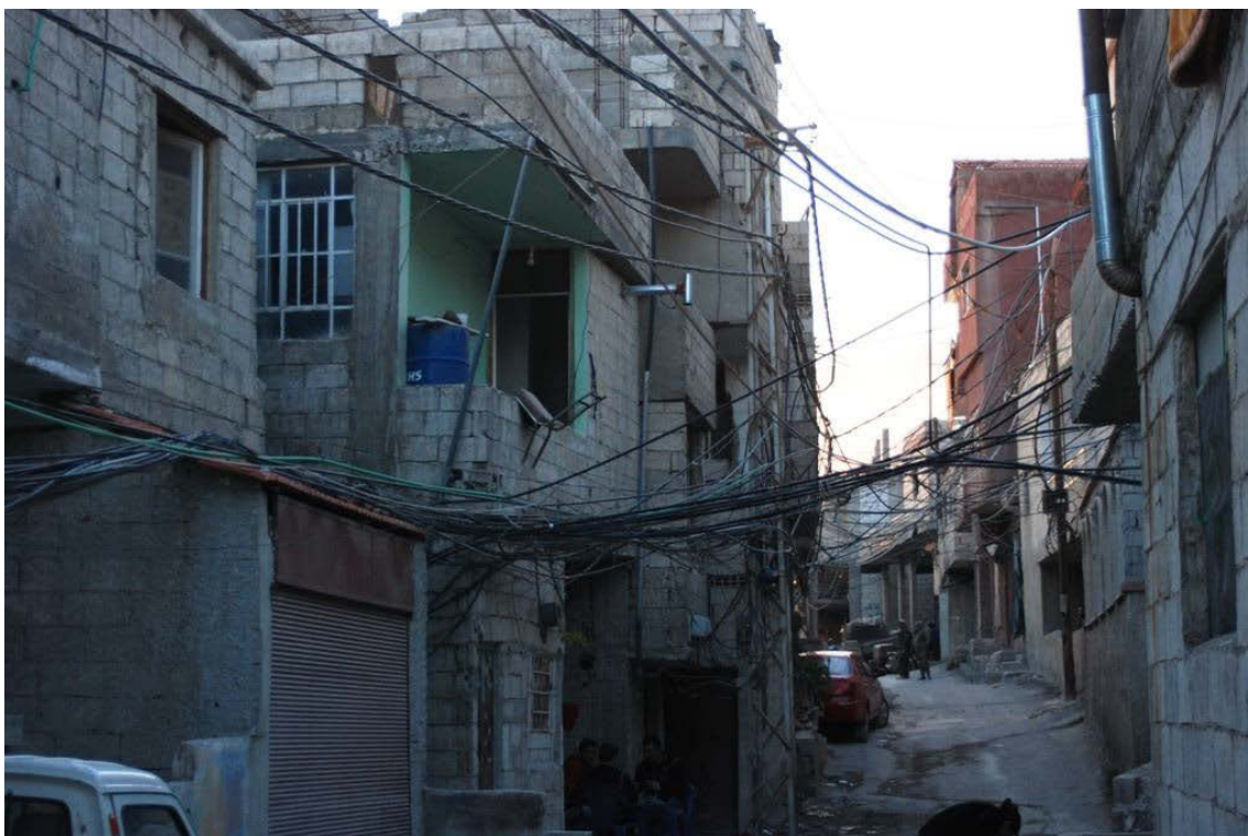
Cliché 43 : les réseaux à Uch Alwarwar. Les réseaux d'eau, d'électricité et de téléphone forment une véritable toile d'araignée qui encombre les ruelles. Cliché André HUMBERT 2010
