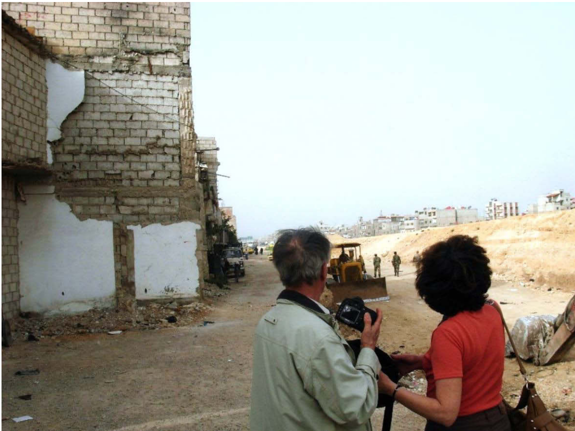
Cliché 20 : Réalisation de la rocade est. La construction de la rocade a détruit une centaine de maisons sur le flanc est du quartier Dweila'a. Cliché : Main Kafa, mars 2010
