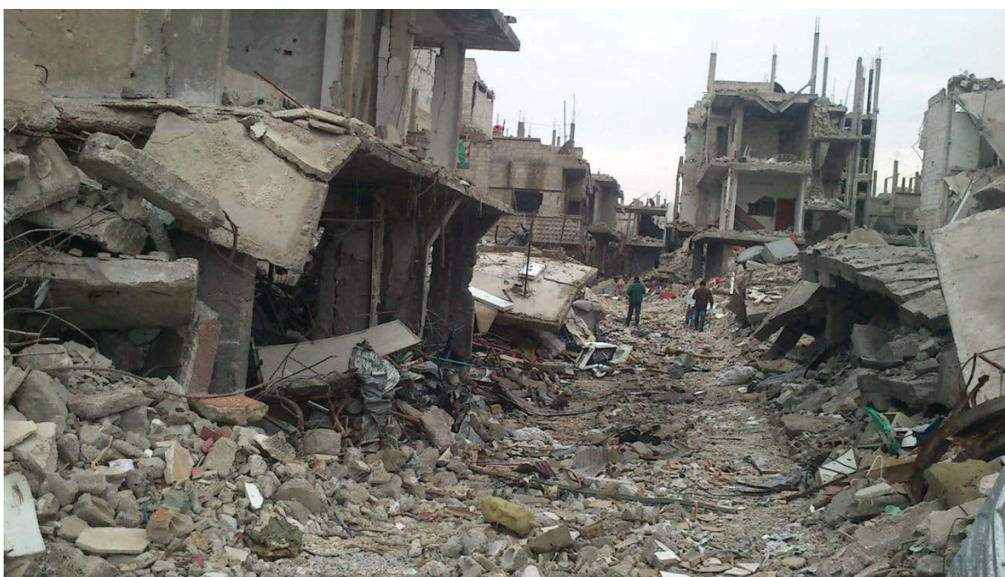
Cliché 49 : Destructons dans le quartier non réglementaire de Tadamoun. Certains quartiers sont très touchés par la guerre qui ravage actuellement la Syrie. Des maisons ont été détruites complètement, d'autres partiellement. Source : https://www.facebook.com/Altdhamen.Revo
