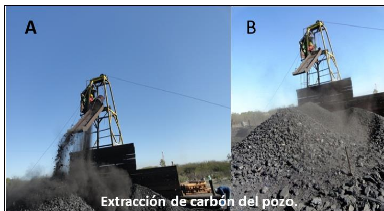
Figura 54. A y B, pozo Migarest, donde se observa la extracción de carbón.
