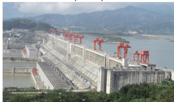
Barrage des Trois-Gorges (Chine)
