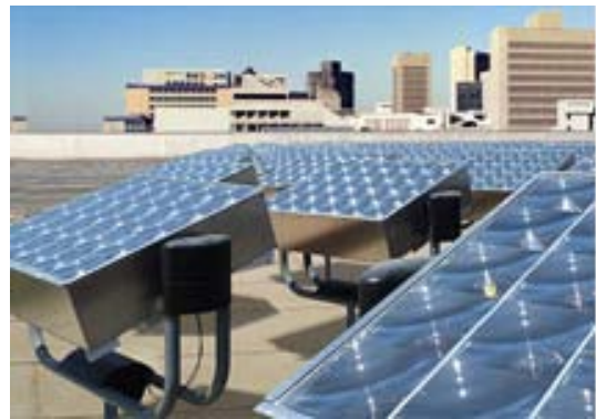
FIGURE A.12 – Cellules à concentration utilisant des lentilles de Fresnel de Energy Innovations [134]
