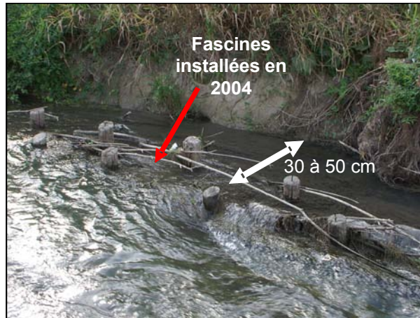
Figure 6.3 : Erosion des berges du Vistre sur la station IS, restaurée hydromorphologiquement (photo : IRSTEA 2011).
