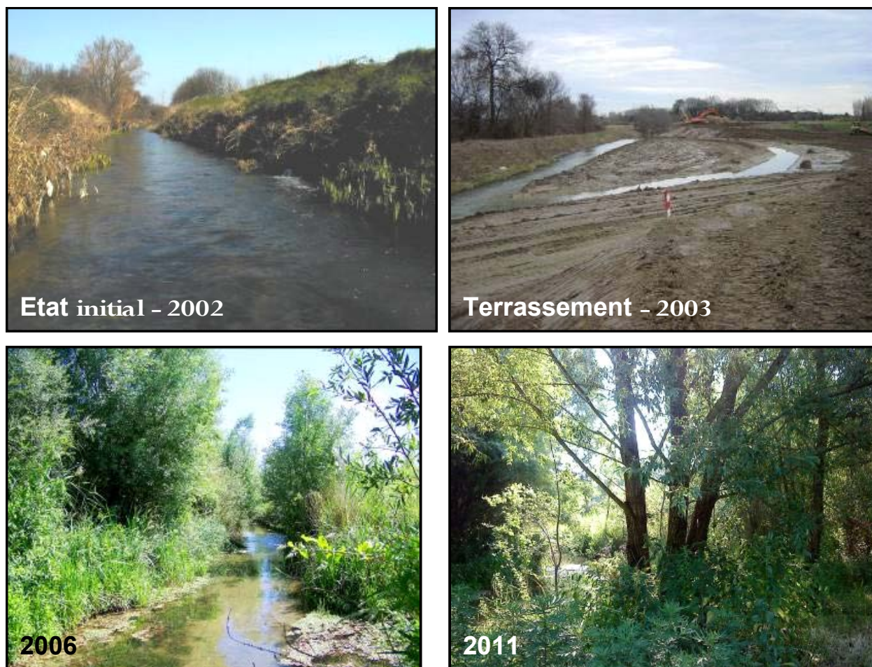
Figure 2.5 : Reméandrage du Vistre dans les anciens bassins de lagunage de Bouillargues : évolution du Vistre de 2002, dans sa configuration canalisée, à 2011, 8 ans après les travaux de restauration. (photos : SMBVV).
