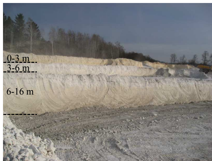
Figure 94 Photo des quatre couches supérieures de l'appendice de la digue de la Crayère
