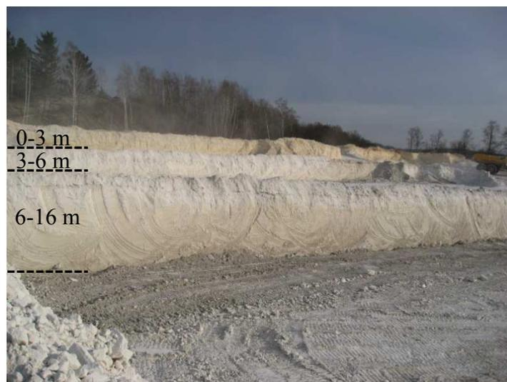
Figure 94 Photo des quatre couches supérieures de l'appendice de la digue de la Crayère
