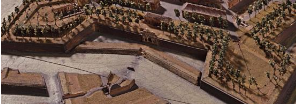
Figure 97. Une tenaille simple sur le plan-relief de Lille.
