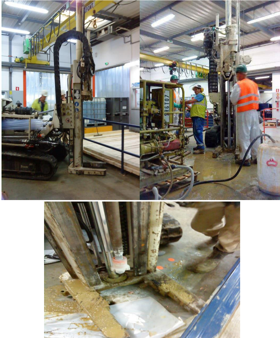
Figure IV-17 : Réalisation des points d'injection avec une foreuse
