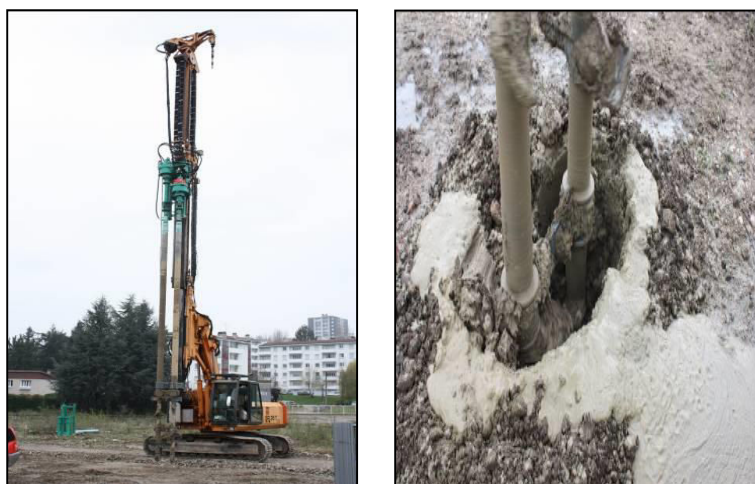
Figure V-2 : Injection du réactif sur terrain par malaxage de sol (photos Soléo Services)
