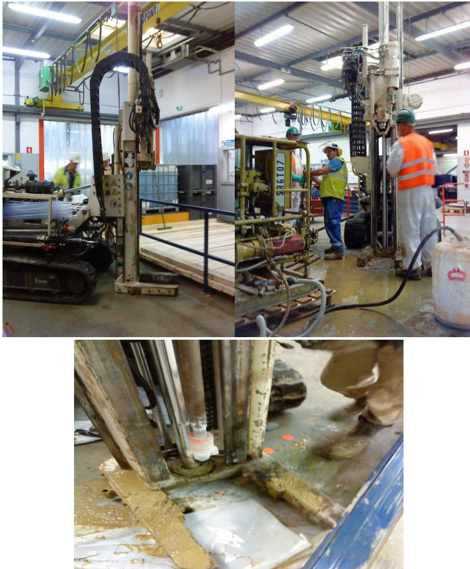
Figure IV-17 : Réalisation des points d'injection avec une foreuse
