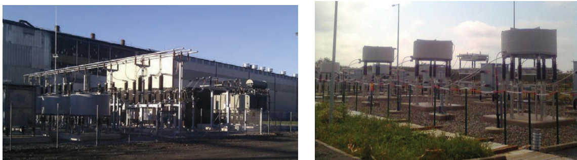
Figure 7 : Filtres passifs du DSVC
