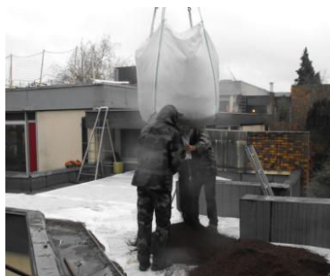
Figure 13 - Substrat versé directement sur la toiture depuis le « big bag »
