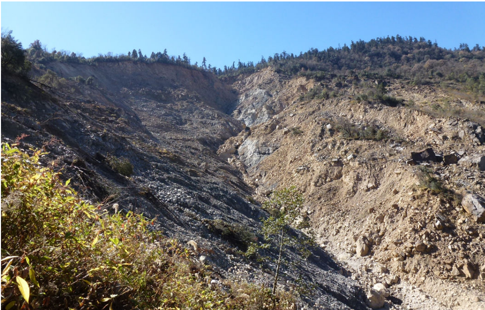
Figure II.12 - Partie sud du glissement de Saituti en novembre 2012
