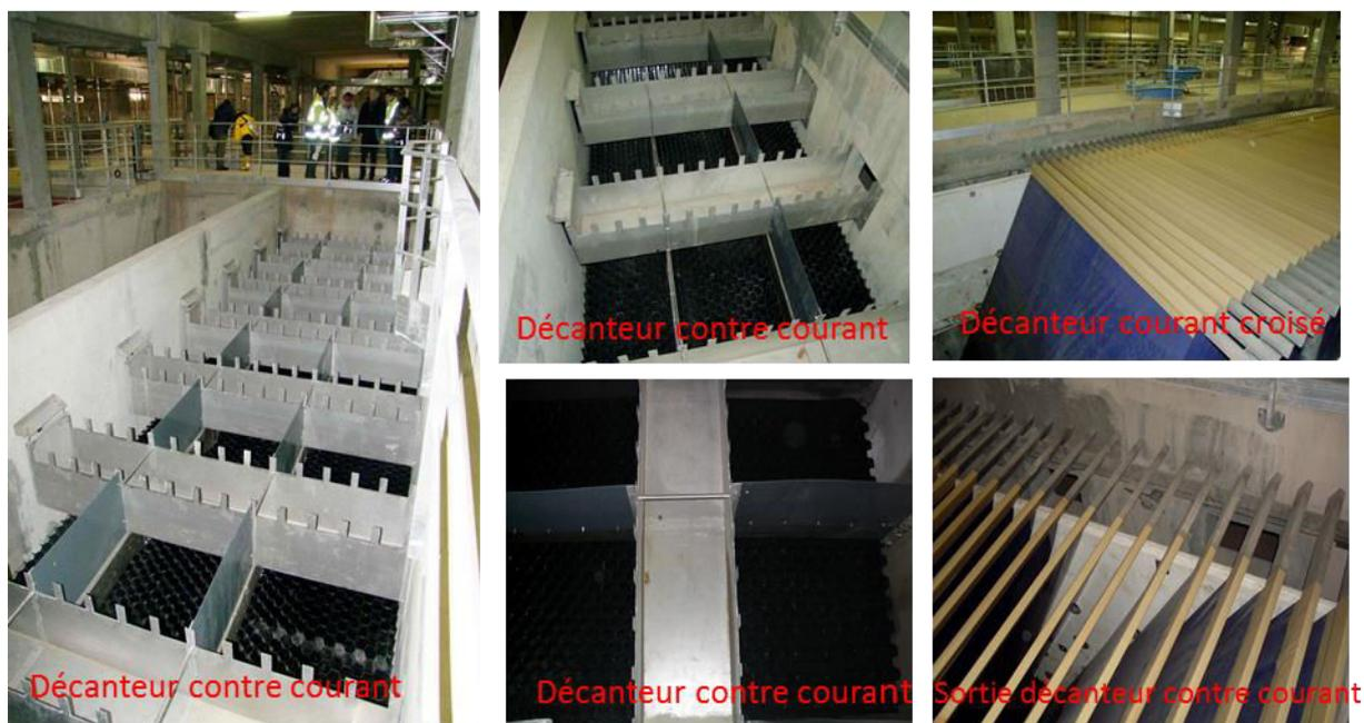
Figure III. 29 : Système de décantation (CUGN).
