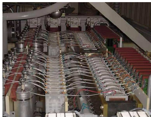
d) Valve élémentaire de 48 thyristors
