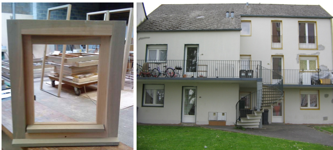
Figure 33 : Fenêtre en hêtre traitée (à gauche) ; Menuiserie en hêtre traité, peintes en blanc en service à Fourmies (à droite)
