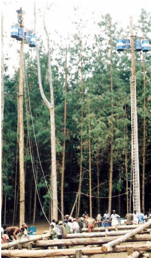
Figure 26 : Photographie d'un chantier de traitement par procédé Boucherie
