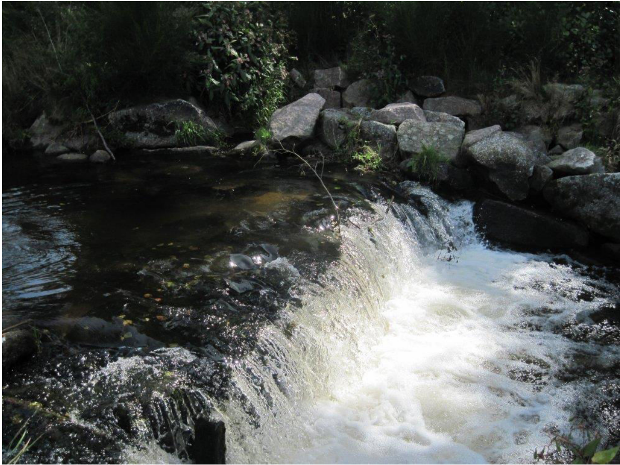
Figure-I-2 - Photo d'un seuil d'aération dans un cours d'eau
