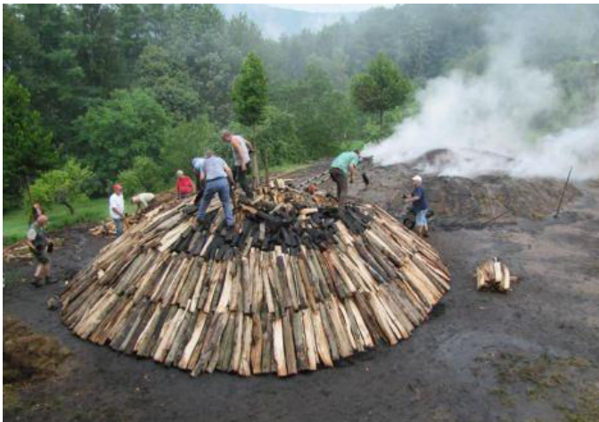
Figure 59 : Montage d'une meule traditionnelle pour produire du charbon de bois (Photo : commune de Lembach)
