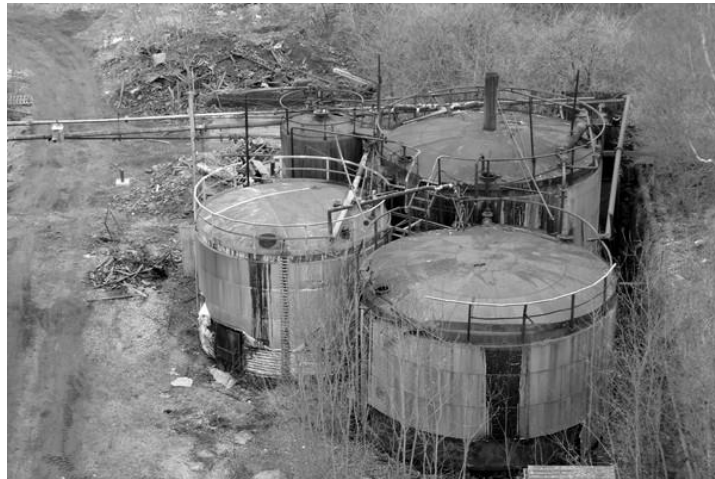
Figure 1-12 : Cuves à goudron de la cokerie d'Anderlues lors de son démantèlement.
