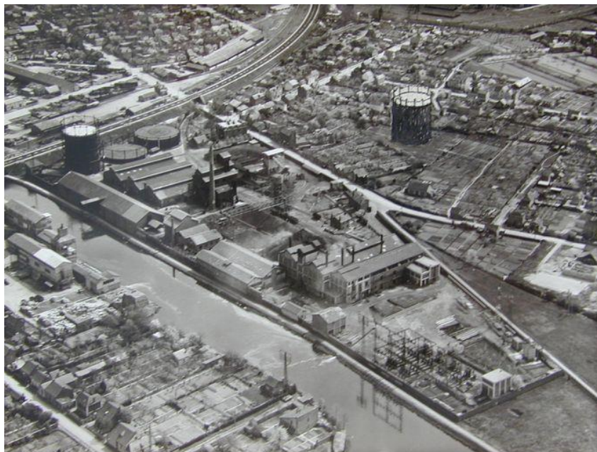
Figure 1-11 : Photo de l'usine à gaz de Rennes (France) dans les années 1950.
