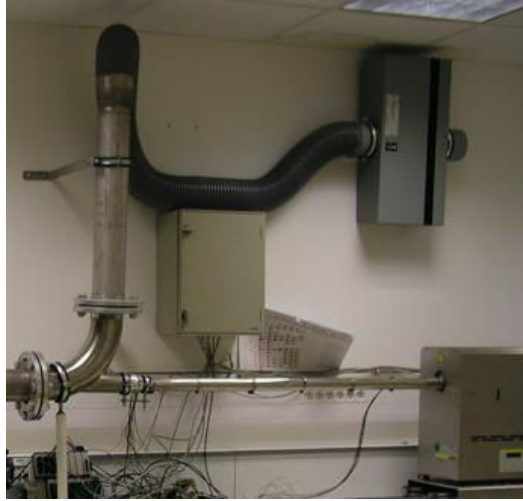
Figure 13. Tube de refroidissement pour une cinétique de 1000K/s.
