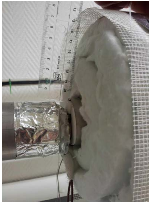
Figure 17. Isolation Kerlane du tube de refroidissement 300K/s
