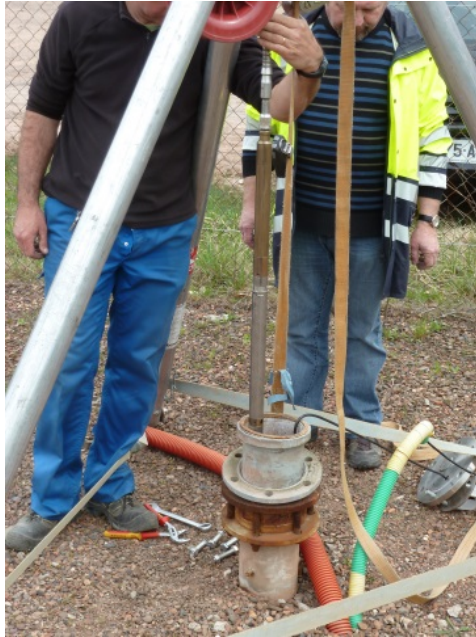
Figure 8 – Mise en place de la sonde TCME3810 dans une conduite débouchant au jour
