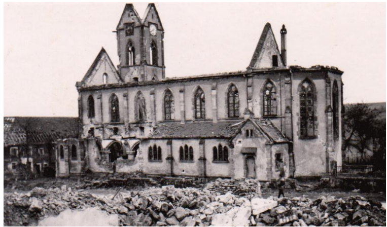
Behren-lès-Forbach déclarée « partiellement détruite ». (coll. Ascomémo)
