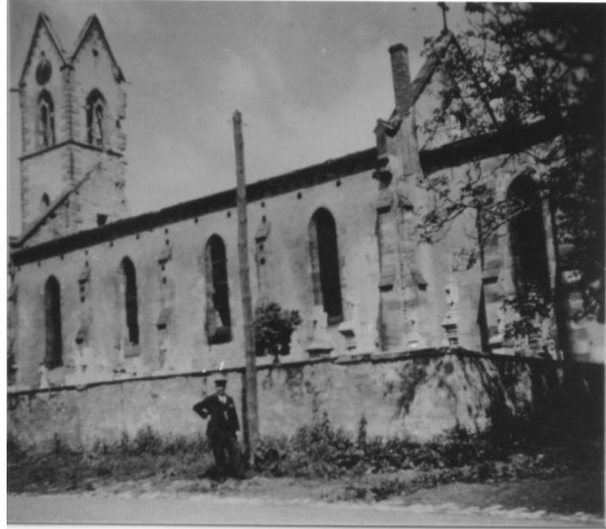
Hoste déclarée « partiellement détruite ». (coll. Philippe Keuer)
