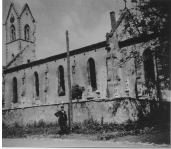
Hoste déclarée « partiellement détruite ». (coll. Philippe Keuer)
