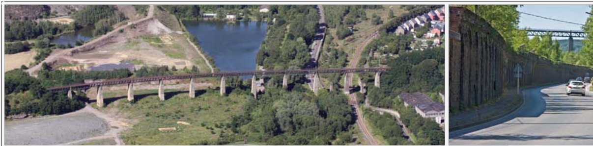
Photos 13 et 14 : Viaduc ferroviaire sur le site transfrontalier de Terre-Rouge (Del Biondo, 2012)
