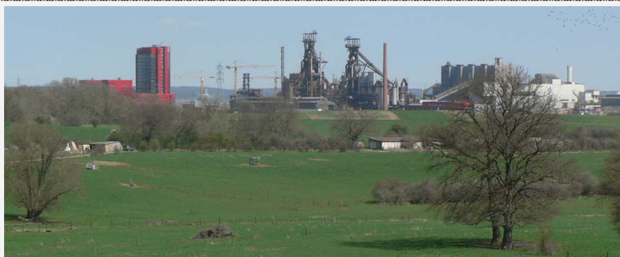
Photo 40 : L'émergence d'une nouvelle silhouette à Belval (Del Biondo, avril 2007)
