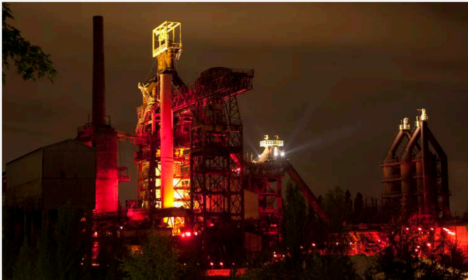
Photo 29 : L'illumination du haut-fourneau U4 (Del Biondo, 2014)
