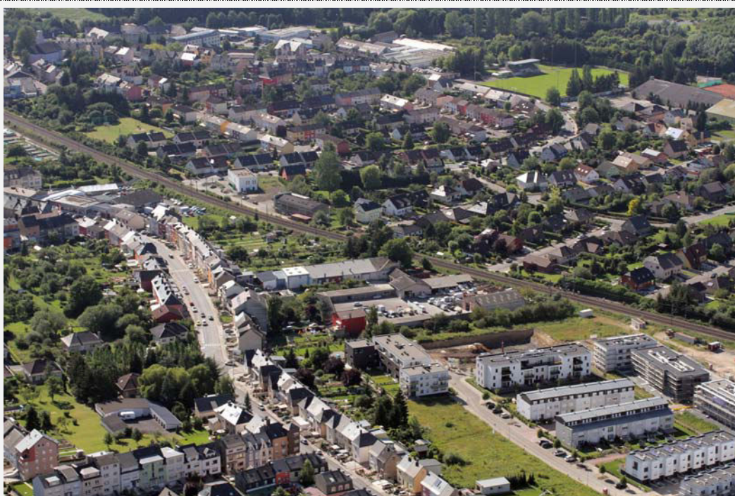
Photo 53 : L'enjeu du raccordement des quartiers nord et sud de Schiffflange (Raybaut, Del Biondo, 2012)
