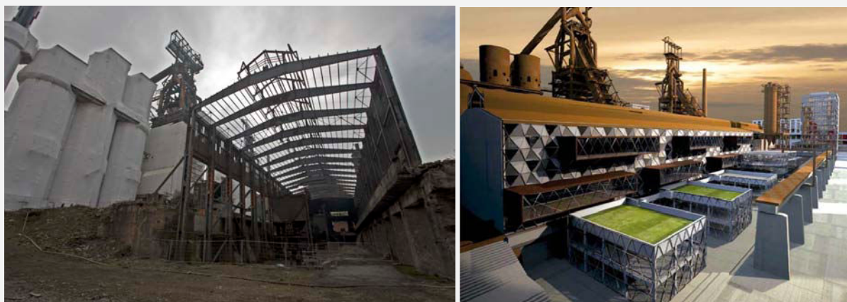
Photo 39 : Le chantier de réhabilitation de la Möllerei (Del Biondo, nov. 2011) Document 16 (photomontage) : L'architecture inédite de la maison du livre et son intégration à l'espace public (Agora, 2012, p. 4)
