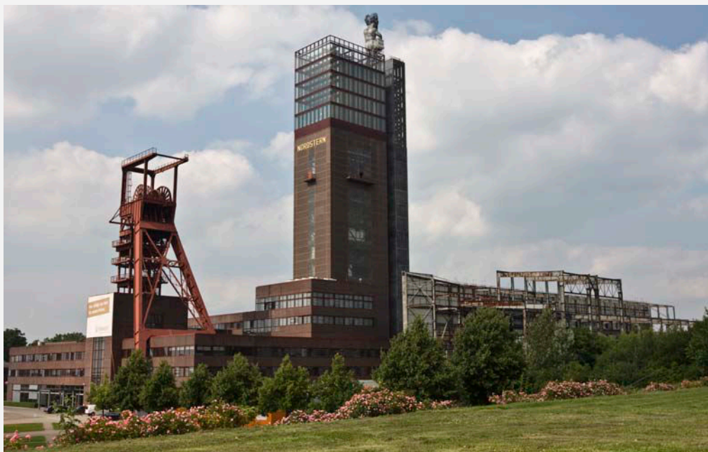
Photo 20 : Le chevalement de Nordstern valorisé au sein d’un nouveau parc urbain (Del Biondo, juin 2012)
