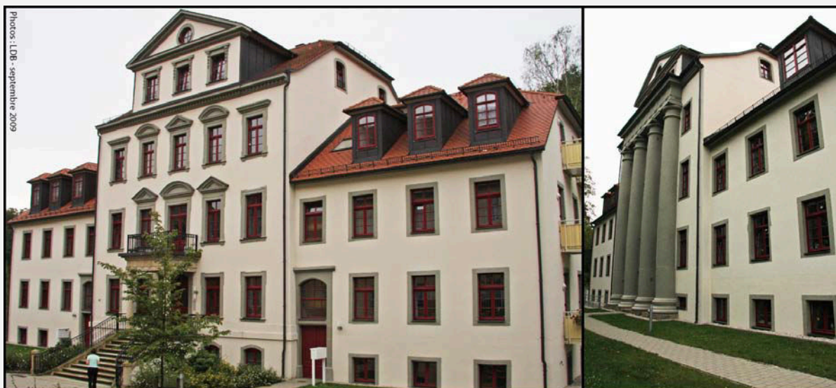
Photos 21 et 22 : L’ancien bâtiment administratif de la manufacture Bernhard (Chemnitz)
