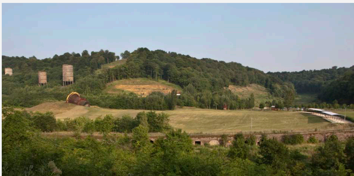
Photo 17 : Les témoins discrets de l'ancienne usine de Senelle à Longwy (Del Biondo, juillet 2013)
