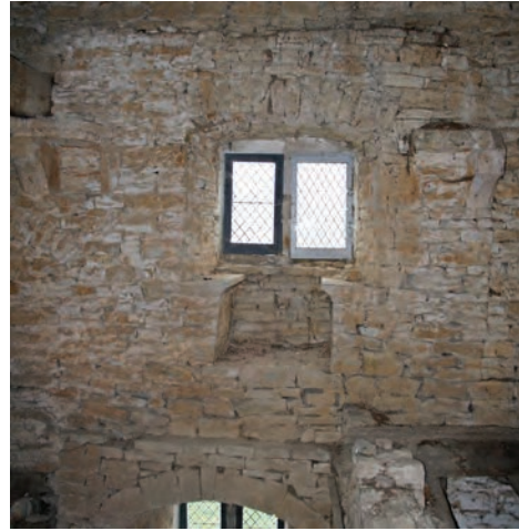
Fenêtre à meneau et embrasure à coussiège de Fondremand (4 e niveau, mur sud, baie centrale)
