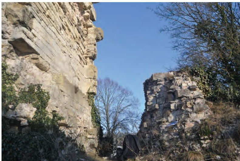
Bainville-aux-Miroirs, embrasure d'une fenêtre probablement à croisée (XV e s.)
