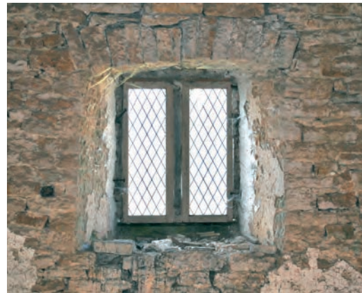
Fondremand, Fenêtre à meneau et une allège haute (5 e niveau, mur ouest); le linteau est monolithe à la différence du type précédent
