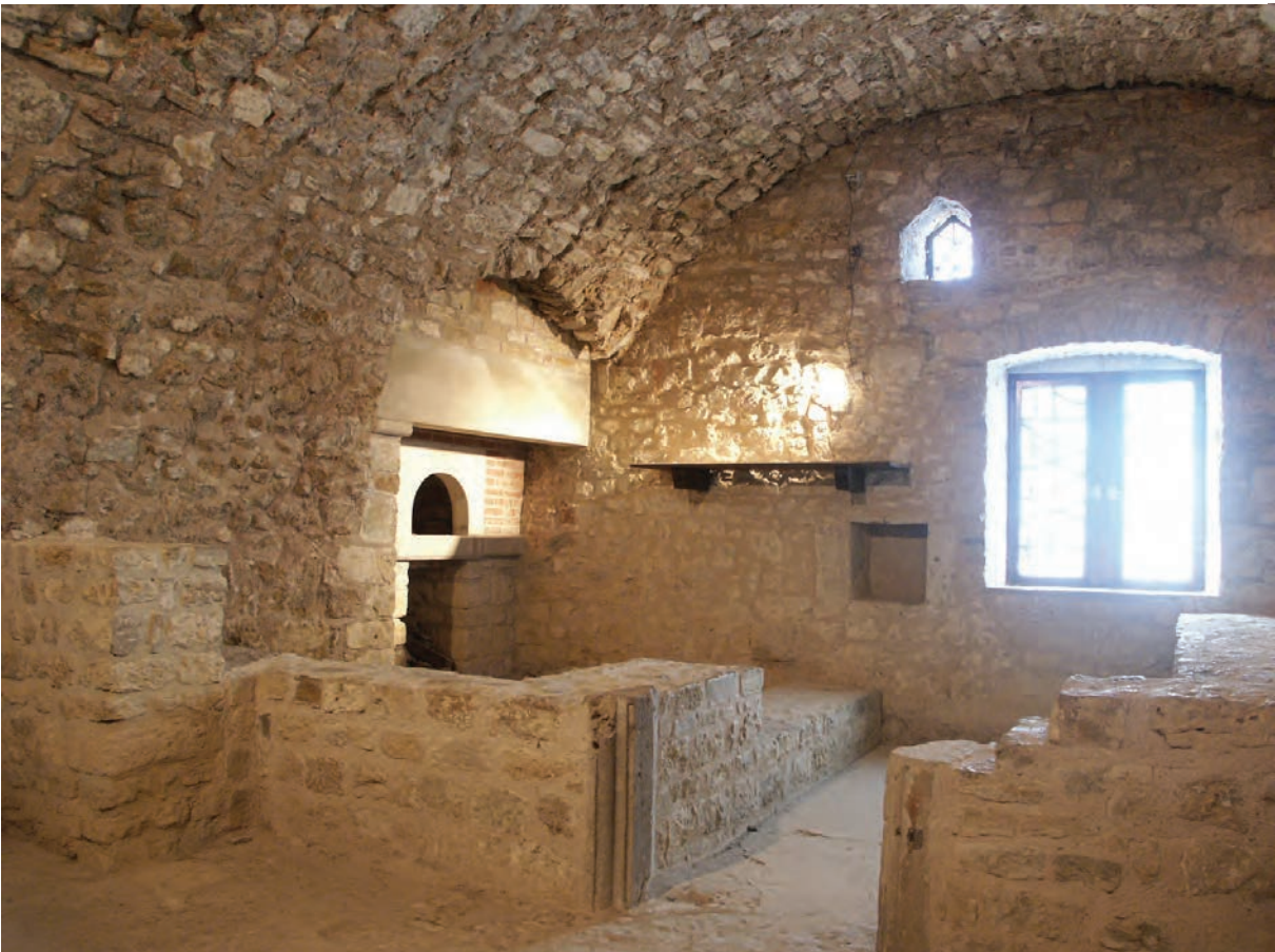
Fig. 85: La boulangerie après restauration (cliché C. Moulis)
