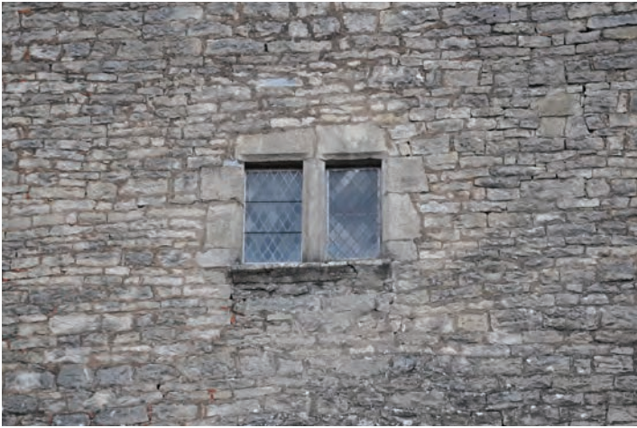
Fenêtre à meneau et embrasure à coussiège de Fondremand (4 e niveau, mur sud, baie centrale)
