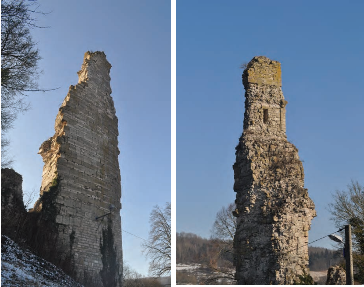
Fig. 64 : Emploi spécifique de matériau à Bainville-aux-Miroirs La cargneule est employée pour le grand appareil extérieur, la dolomie pour l'essentiel du gros œuvre
