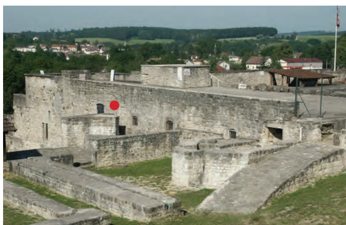
Fig. 82: Vue du soubassement de l'Hôtel dit Neufchâtel depuis l'est (cliché C. Moulis)
