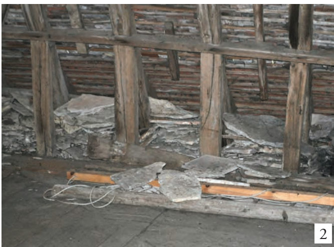
Fig. 74 : Laves calcaires du château de Fondremand 1 : Fermeture d'avant-toit | 2 : Laves stockées | 3 : Laves en place sur l'égout de la tourelle
