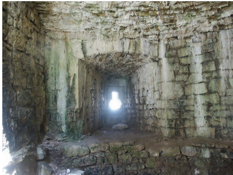
Tour orientale de la fausse-braie nord, canonnière occidentale
