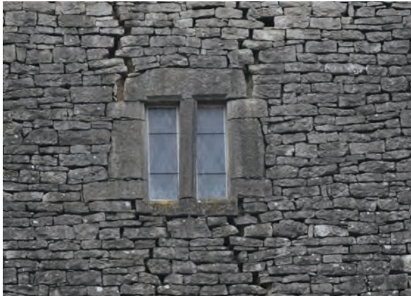
Fondremand, Fenêtre à meneau et une allège haute (5 e niveau, mur ouest); le linteau est monolithe à la différence du type précédent
