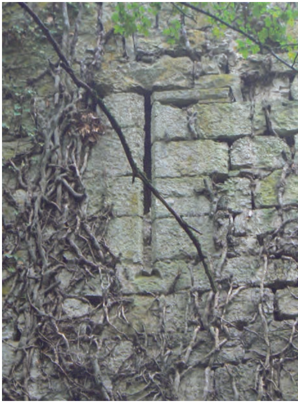
Archère à étrier de la tour du Châtelot (XIII e s.)
