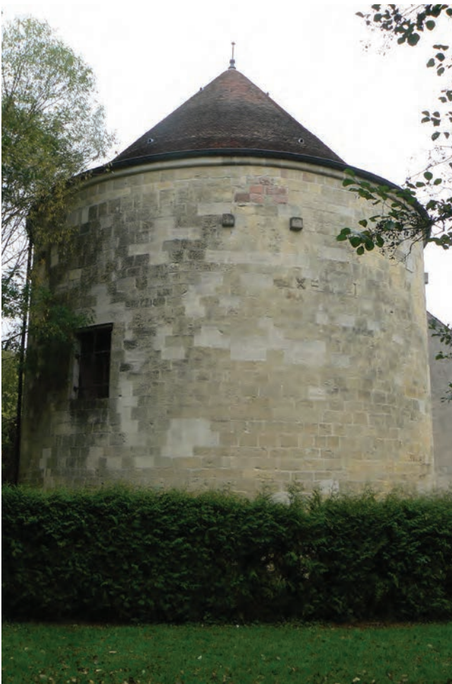
Fig. 61 b : Exemples de constructions en pierre de taille (en bas) ou moellons (en haut) de moyen à grand module. En bas à gauche : Amance, à droite : la tour des Lombards de Fontenoy ; en haut, la tour sud-est de l'enceinte urbaine de Neufchâtel Les triangles indiquent des assises de réglage
