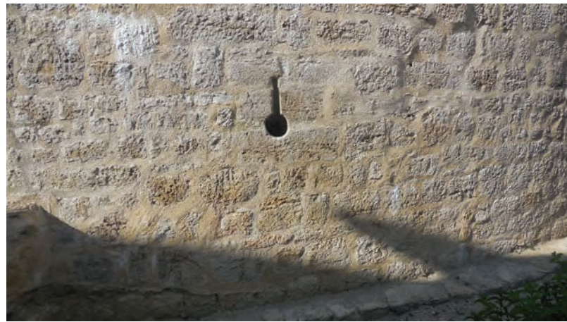
Chemise d'artillerie sud (intérieur / extérieur)
