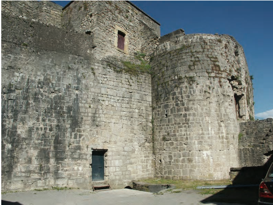
Poterne de la chemise d'artillerie méridionale de Châtel-sur-Moselle (XV e s.)
