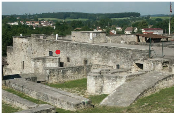
Fig. 82: Vue du soubassement de l'Hôtel dit Neufchâtel depuis l'est (cliché C. Moulis)
