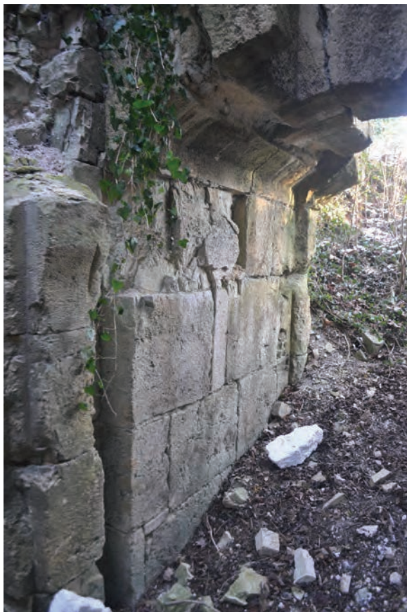
Gaine de herse de l'entrée du château de Bainville-aux-Miroirs
