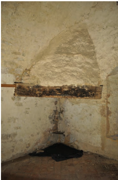
Fondremand, 2 e niveau cheminée d'angle (fin XIV e s.)
