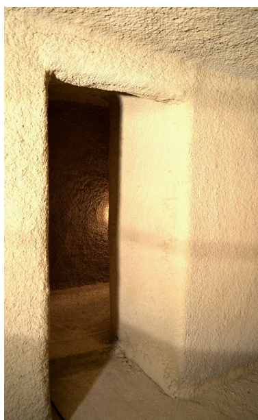
(a) Vue du sas depuis la pièce
