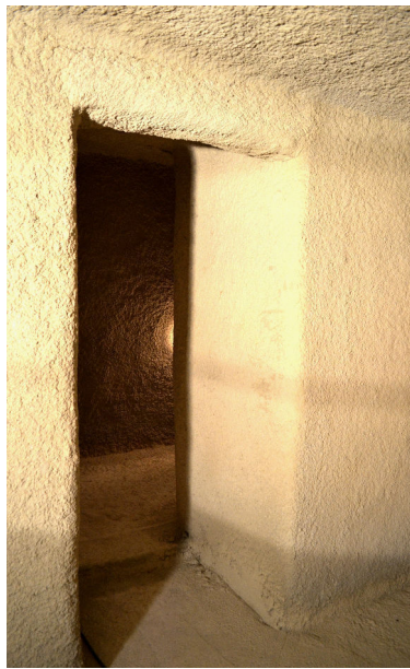
(a) Vue du sas depuis la pièce
