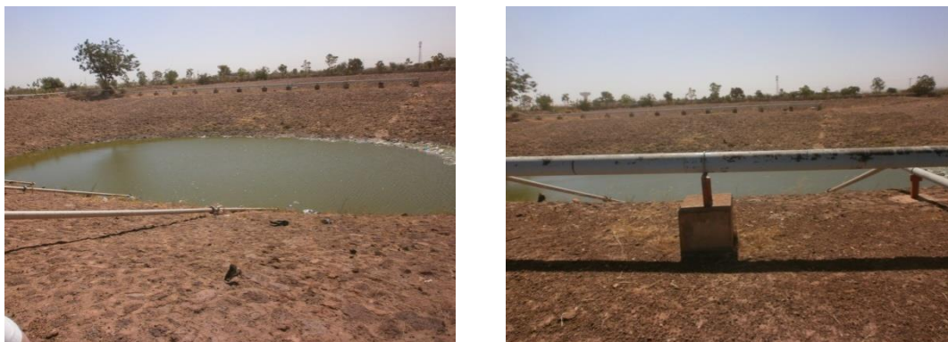
Photo 17 : Bassins de lixiviats du CTVD de Ouagadougou au Burkina Faso
