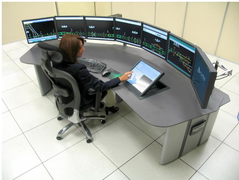
Fig 4-4 Centre de contrôle de CESIR
