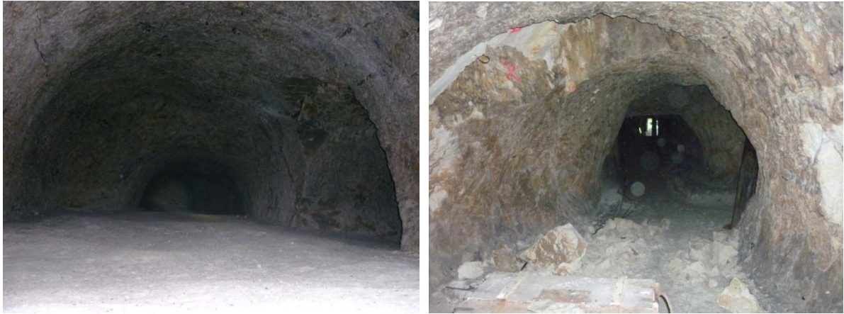
Figure II.13 : Vues des galeries de la carrière de Château-Landon (Crédit : INERIS)
