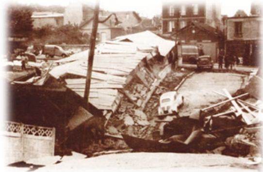
Effondrement de Clamart (1961)
