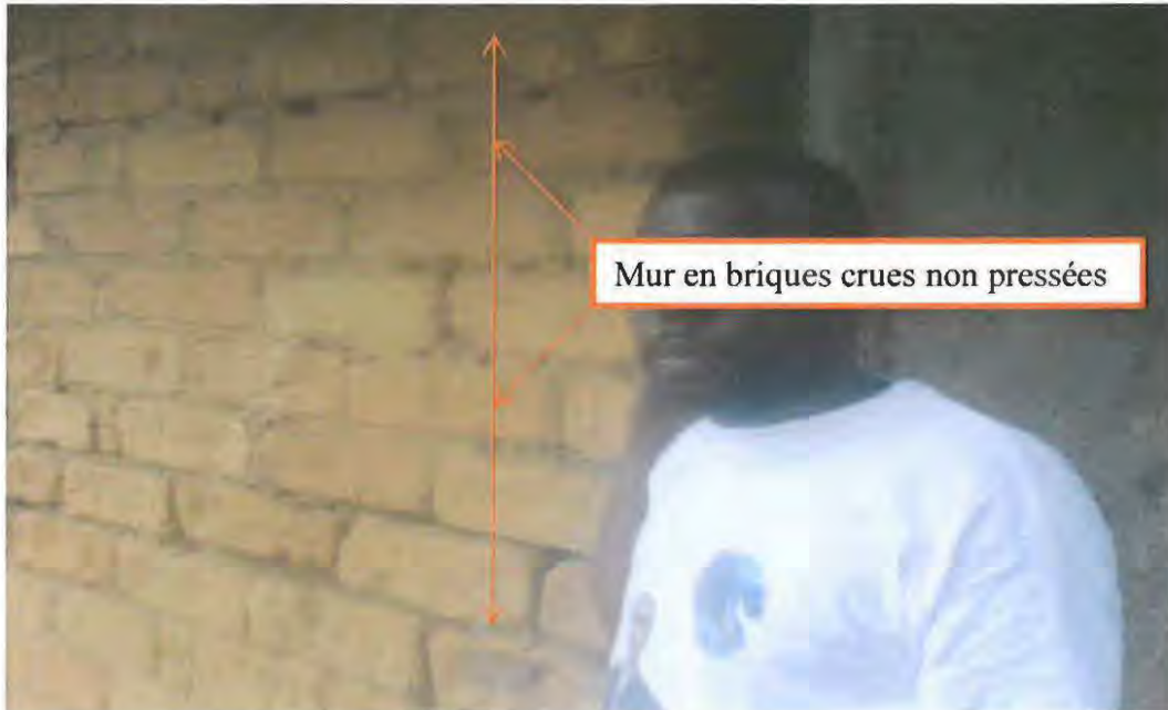
Figure IV.3.2 : Mur en briques crues non pressées traditionnelles au Gabon
