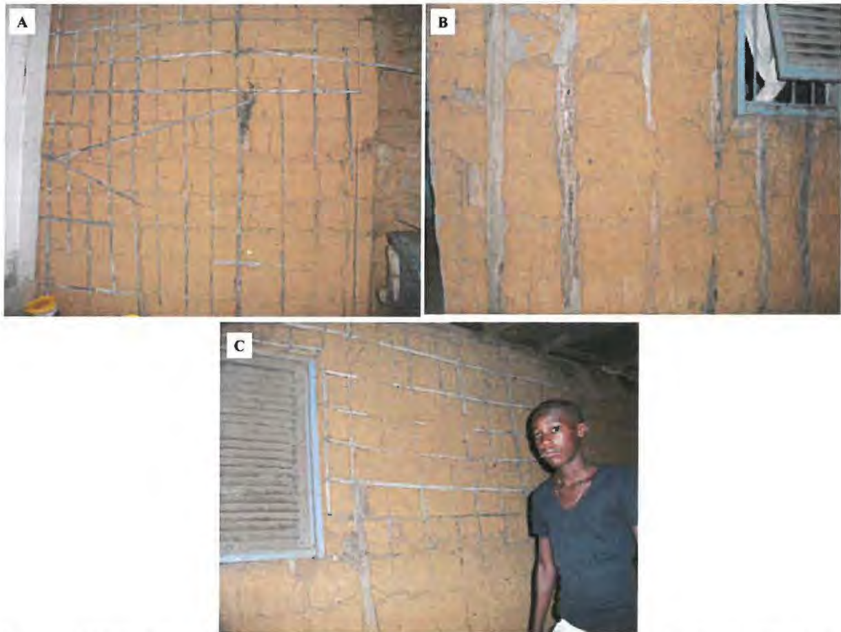
Figure IV.3.1 : Murs d'une maison en terre battue (quartier pk6) à Libreville face arrière (A), face latérale (B) et de face principale (C)
