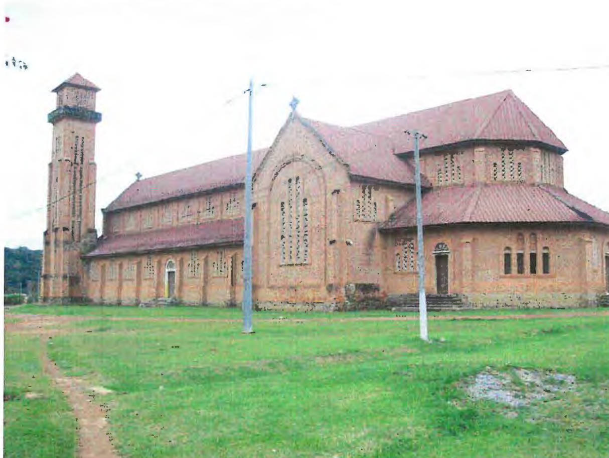
Figure IV.5 : Architecture et beauté de la brique cuite au Gabon : cas de l'Eglise d'Angone au Nord du Gabon de l'Epoque Coloniale
