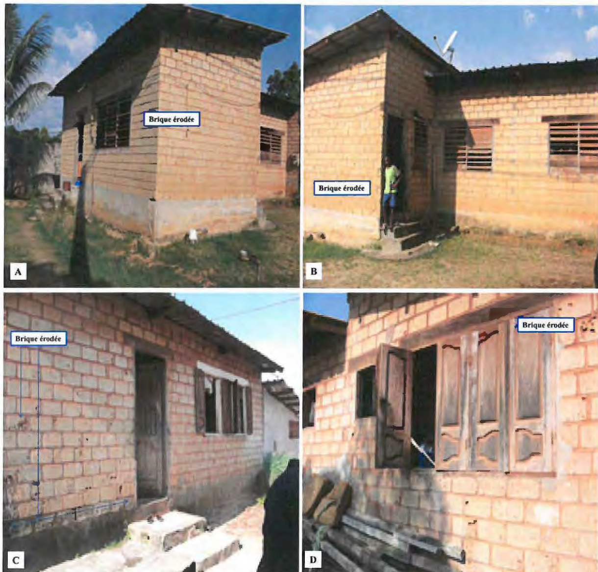
Figure IV.2.2 : Maisons témoins de l'unité de transformation de Nzeng-Ayong. Villa n°15 (A), Villa n°24 (B) et Villa n°17 vue de face (C) et vue arrière (D)
