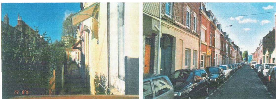
Maisons ouvrières en cour
