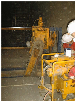
Figure 46 : Réalisation de l’excavation de la tranchée
