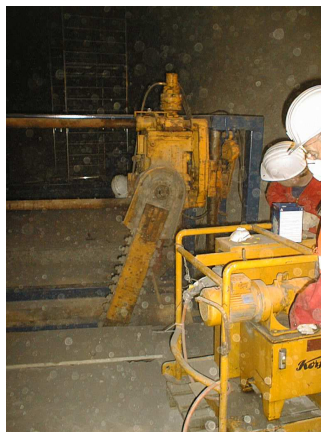
Figure 46 : Réalisation de l’excavation de la tranchée
